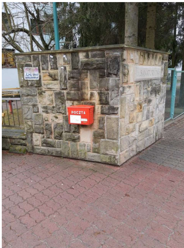
Schody zewnętrzne 2C - murek przy wejściu głównym
