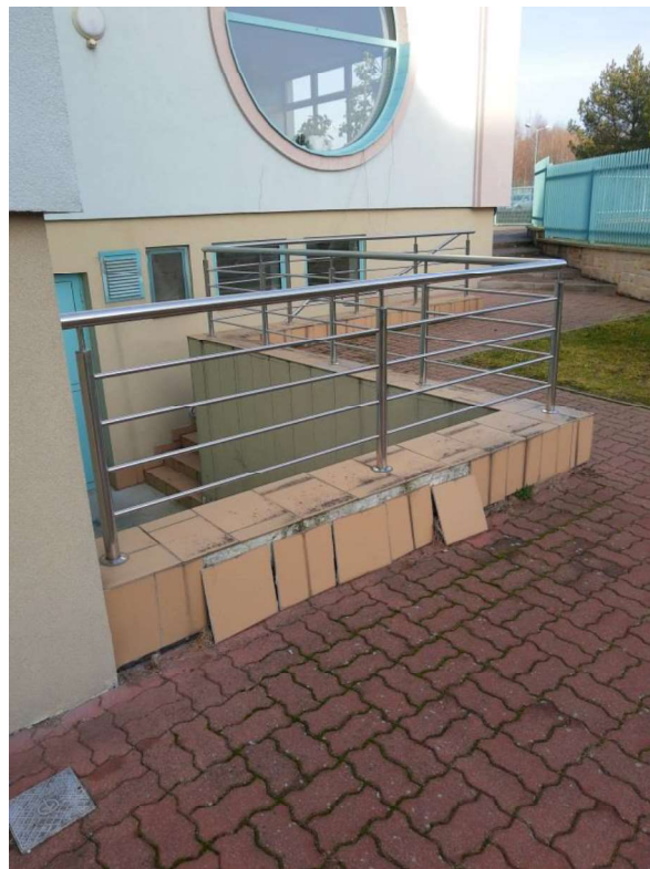
Schody zewnętrzne Basen 3
