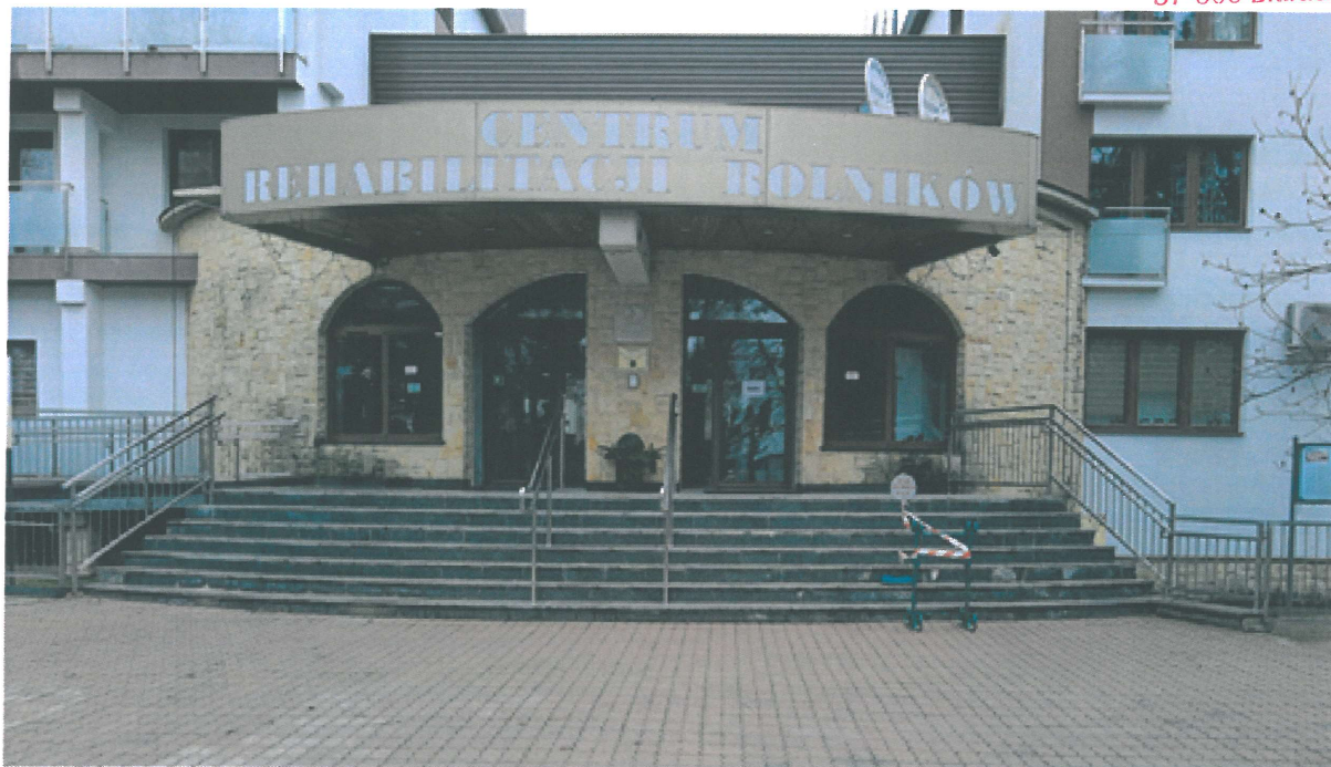
Schody zewnętrzne do głównego wejścia
