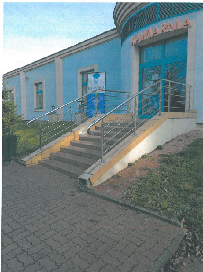
Schody zewnętrzne do kawiarni przy basenie
