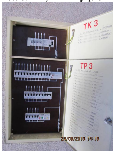
Foto 5. TP3, TK3- III piętro
