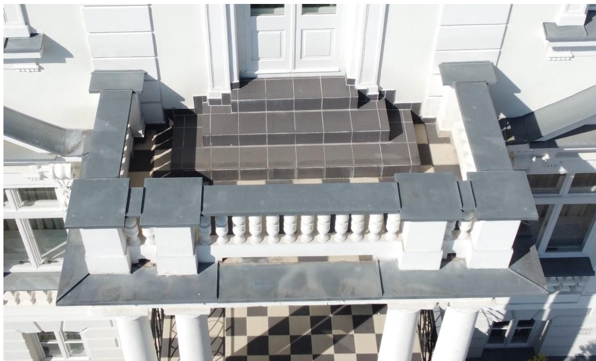
Zdjęcie 12. Balkon na piętrze, na elewacji tylnej, południowo-wschodniej
