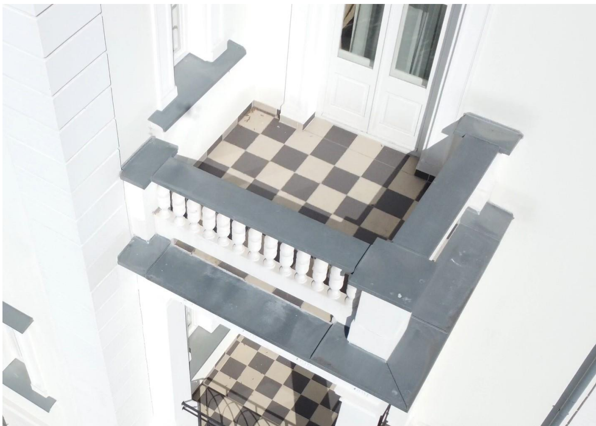
Zdjęcie 10. Balkon na piętrze, narożny od strony wschodniej, na elewacji bocznej, południowo-zachodniej
