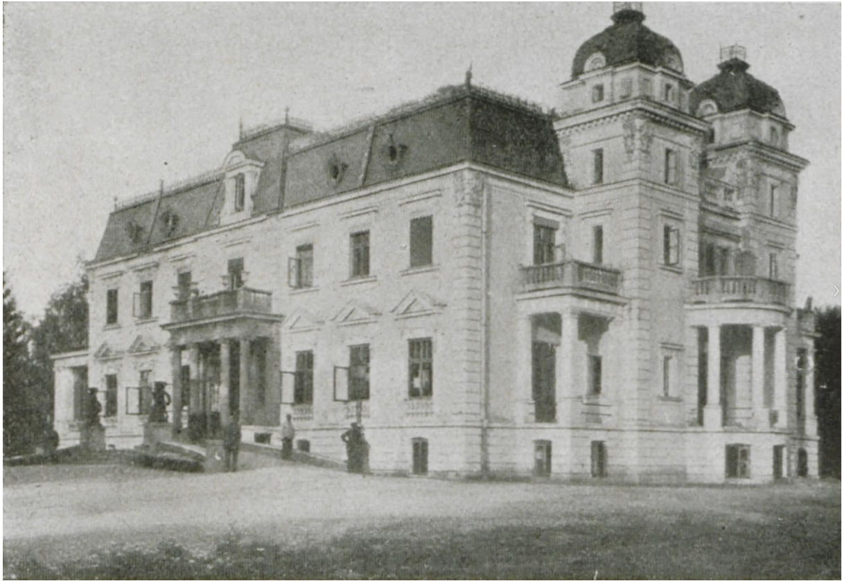
1. Pałac w Teresinie w latach 1914-1915. Widoczny balkon na wejściu głównym oraz balkony w dwóch kondygnacjach elewacji południowo-zachodniej.
