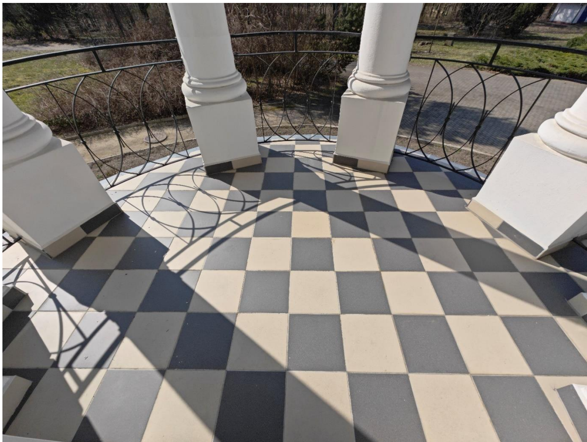
Zdjęcie 30. Balkon wysokiego parteru elewacji bocznej. Dobry stan zachowania w porównaniu z pozostałymi balkonami może wynikać z korzystnego położenia tego balkonu względem warunków atmosferycznych (mniejsza ekspozycja na deszcz i śnieg), prawidłowo wykonanych spadków posadzki. Miejscowo widoczne są jedynie drobne ubytki i przebarwienia spoin oraz niewielkie spękania w strefach styku z cokołami.
