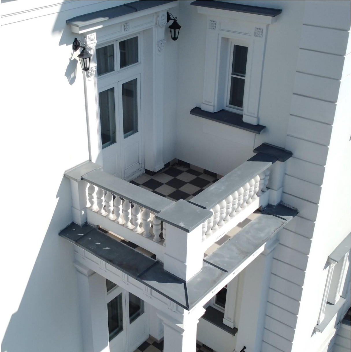
Zdjęcie 8. Balkon na piętrze, narożny od strony zachodniej, na elewacji bocznej, południowo-zachodniej.
