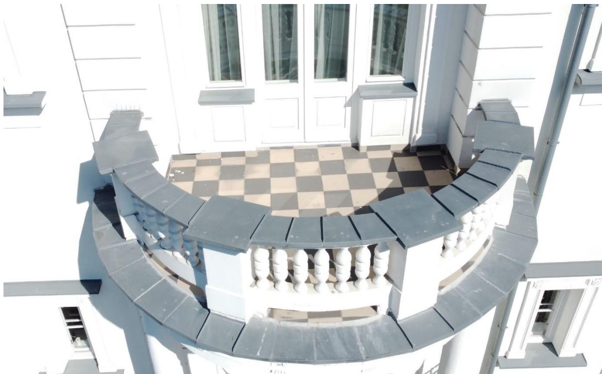
Zdjęcie 9. Balkon na piętrze środkowy, na elewacji bocznej, południowo-zachodniej.
