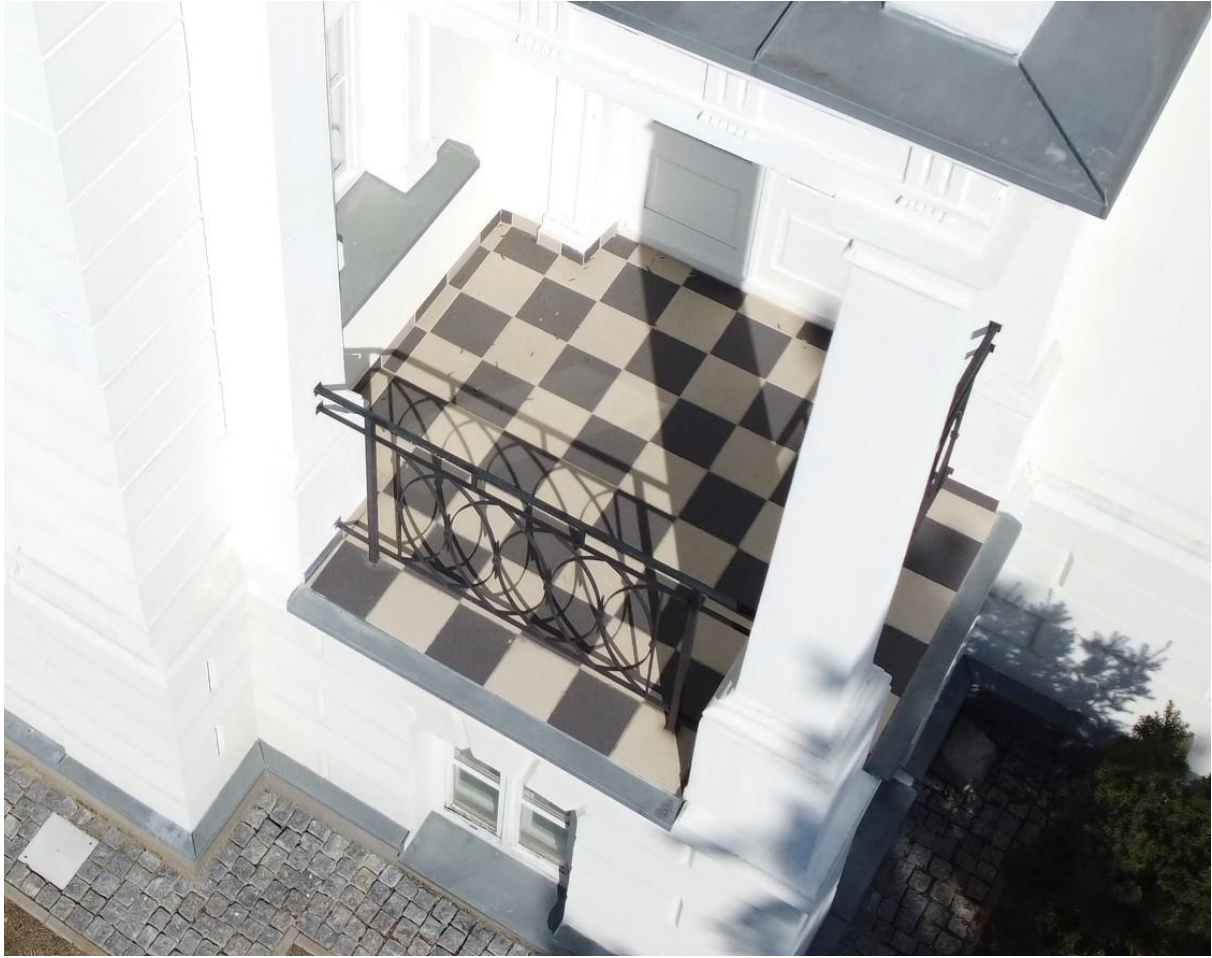
Zdjęcie 7. Balkon na wysokim parterze, narożny od strony wschodniej, na elewacji bocznej, południowo-zachodniej.
