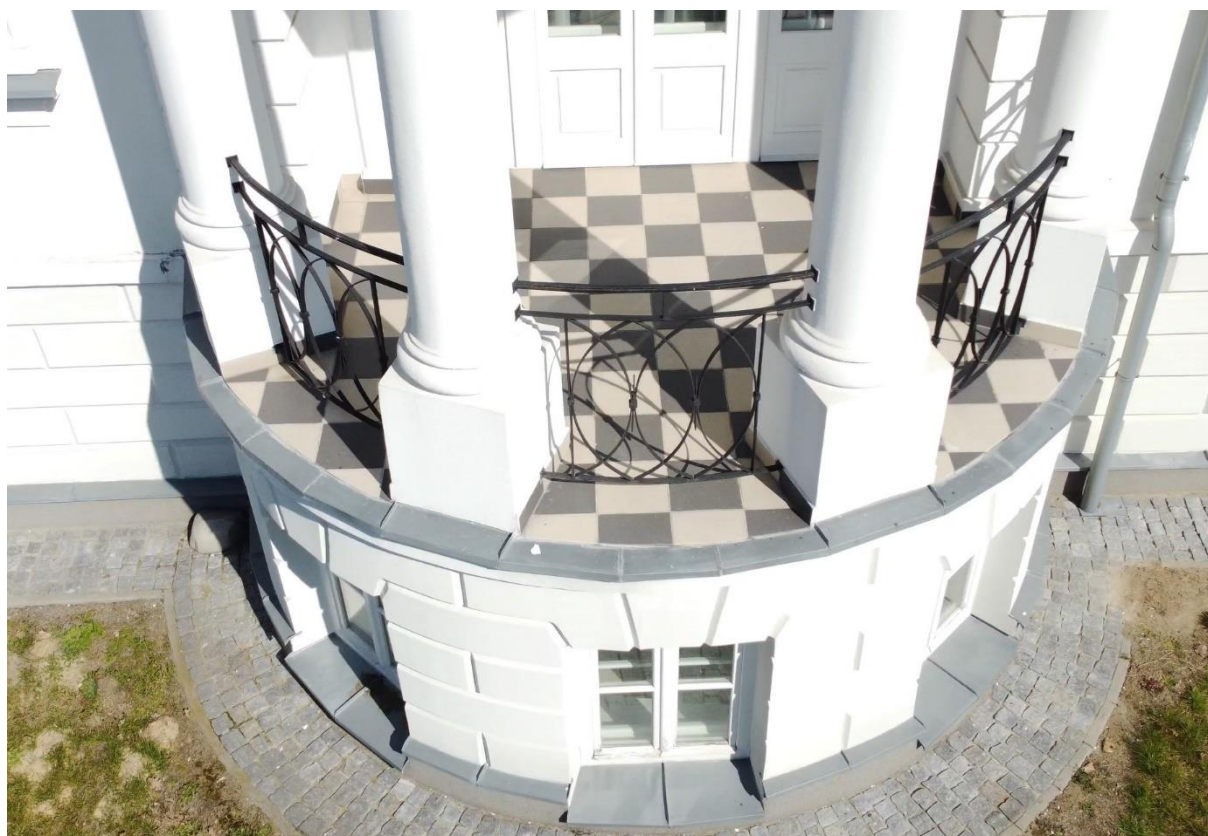
Zdjęcie 6. Balkon na wysokim parterze środkowy, na elewacji bocznej, południowo-zachodniej.
