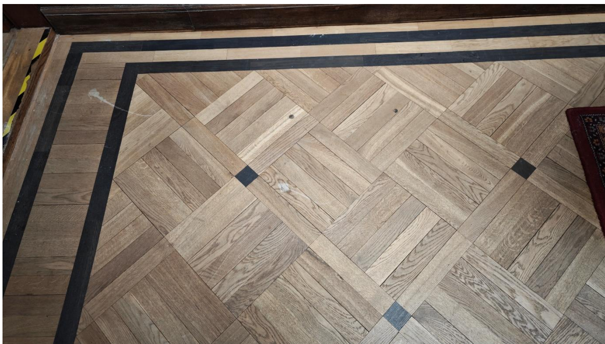
Zdjęcie 13. Fragment reprezentacyjnej części parkietu z dekoracyjną bordiurą i czarnymi, kontrastującymi wstawkami narożnymi. Na powierzchni widoczne są liczne ślady zużycia – przebarwienia, rysy oraz jaśniejsze i ciemniejsze plamy wynikające z eksploatacji i nierównomiernego zużycia warstwy wykończeniowej. Po lewej stronie zaznacza się wyraźne, jasne odbarwienie drewna.
