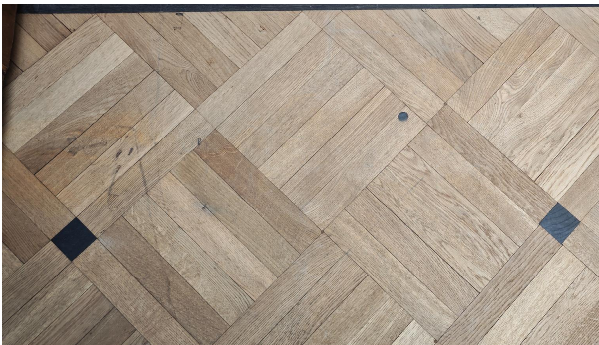
Zdjęcie 14. Fragment parkietu pałacowego z widocznymi dekoracyjnymi narożnymi wstawkami w kontrastowym kolorze. Na powierzchni deszczutek zidentyfikowano liczne ślady użytkowania, w tym wyraźne ciemne zarysowania (prawdopodobnie od przesuwanych mebli), miejscowe przebarwienia oraz punktowe odbarwienie drewna. Uwidacznia się także różnica w tonacji kolorystycznej między poszczególnymi elementami, wymagająca ujednolicenia w toku prac konserwatorskich.
