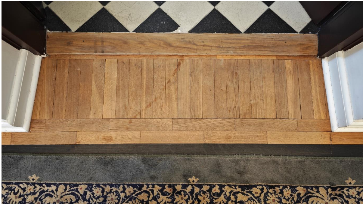
Zdjęcie 12. Widok drewnianej listwy progowej w przejściu między pomieszczeniami o różnym wykończeniu posadzek – parkietem i płytkami ceramicznymi. Na powierzchni listwy widoczne są zabrudzenia oraz miejscowe odbarwienia, co może świadczyć o długotrwałej eksploatacji bez odpowiedniej pielęgnacji. Zauważalne jest także niedopasowanie kolorystyczne listwy do sąsiadujących elementów parkietu, co obniża walory estetyczne wykończenia. Na środku parkietu widoczna jest ciemna, nieregularna plama, która może być wynikiem miejscowego zalania lub kontaktu z substancją chemiczną.
