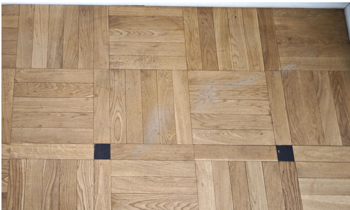
Zdjęcie 15. Fragment parkietu pałacowego z charakterystycznymi czarnymi narożnymi wstawkami dekoracyjnymi. W centralnej części jednego z kasetonów widoczne jest lokalne zmatowienie powierzchni drewna, bezpośrednio otaczające zarysowanie – najprawdopodobniej efekt próby doraźnego usunięcia rysy poprzez miejscowe szlifowanie lub intensywne czyszczenie. Działanie to spowodowało wyraźną różnicę w połysku i kolorystyce względem sąsiednich elementów parkietu.
