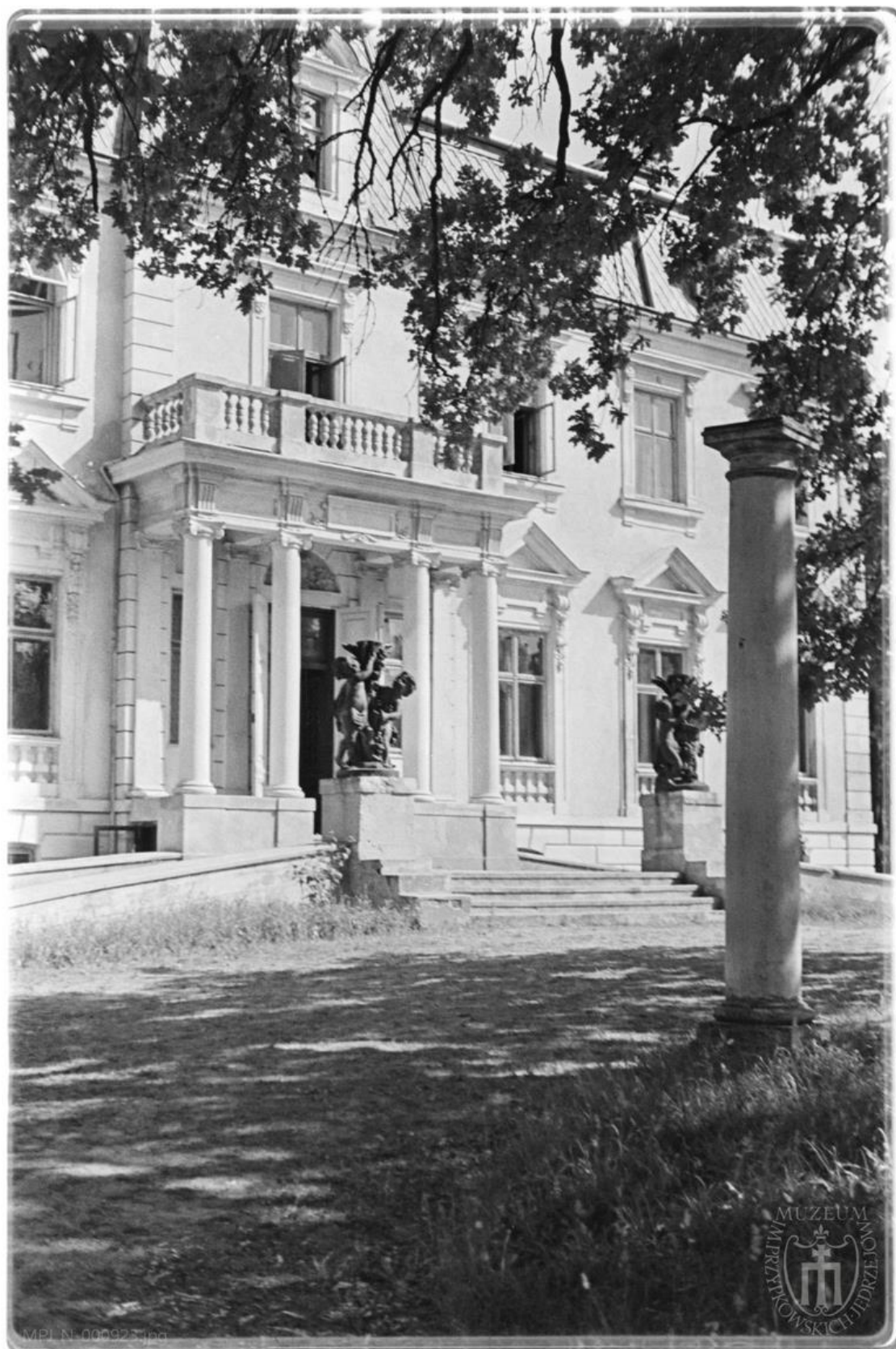
2. Fragment elewacji frontowej pałacu w Teresinie w latach 1935-1939. Stolarka otworowa malowana na biało, ze zmienionymi podziałami. Źródło: zbiory Muzeum im. Przypkowskich w Jędrzejowie
