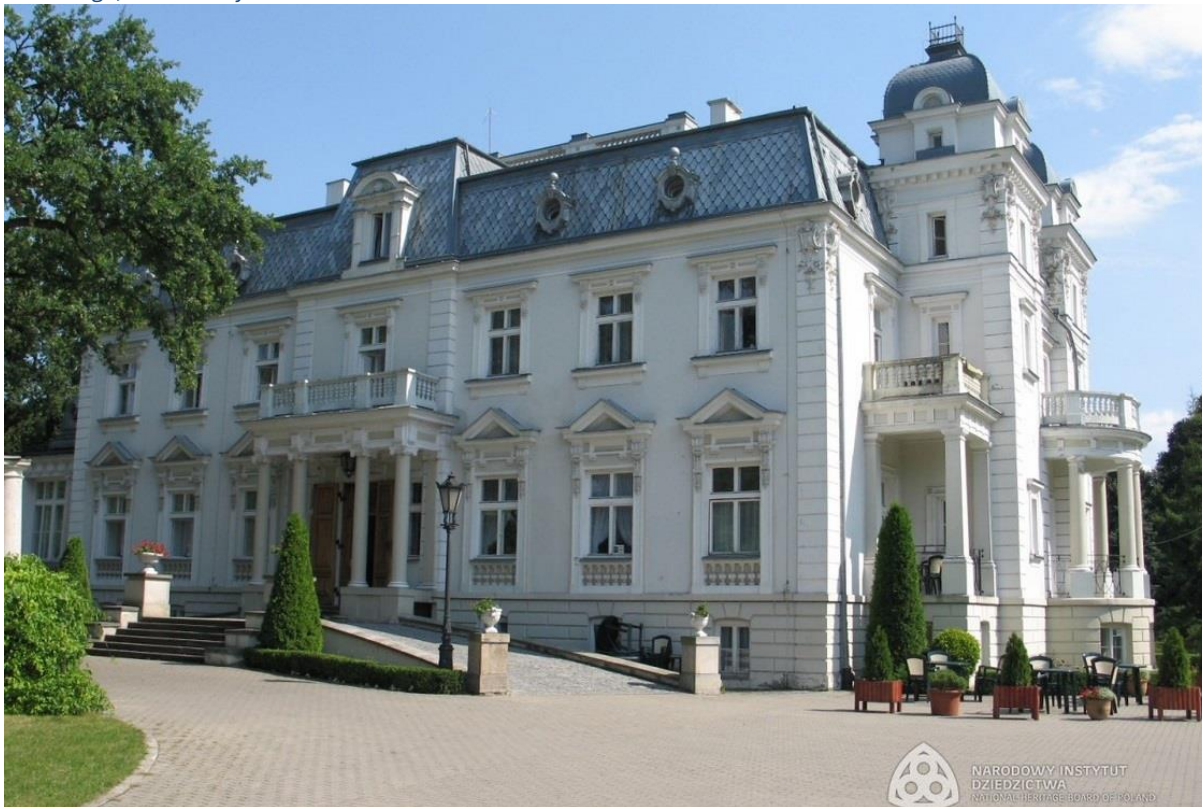
4. Widok ogólny na elewację frontową pałacu, rok 2012. Źródło: Narodowy Instytut Dziedzictwa, fot. fot. B. Modrzewski
